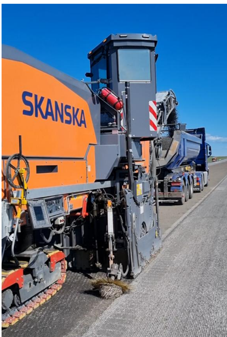
Figur 2 Uppfräsning av gammal polymermodifierad beläggning på flygplats.
